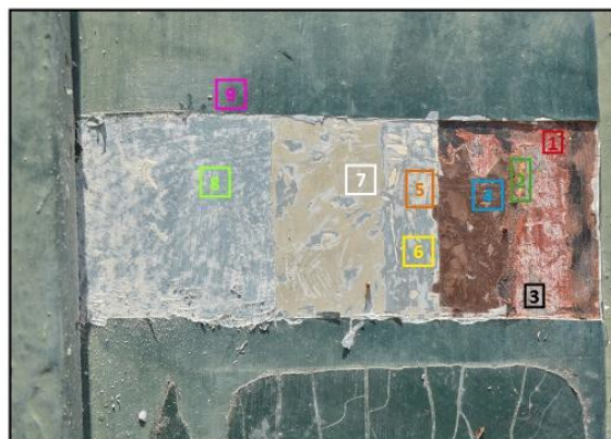
Εικ.28. Μεταλλική θύρα εισόδου, Βόρεια όψη ισόγειο, (1) μίνιο, (2) ώχρα, (3) γκρι, (4) καφέ, (5) υπόλευκο, (6) γκρι μπλε, (7) μπλε, (8) γκρι μπλε, (9) πράσινο.
