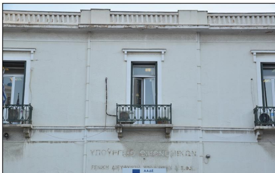
Εικ.3. Λεπτομέρεια του άνω κεντρικού τμήματος της βόρειας όψης.
