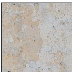
Εικ.15. Μικρορωγματώσεις των στρωμάτων των βαφών.
