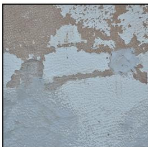
Εικ.10. Τοπικές αποκαταστάσεις του επιχρίσματος.
