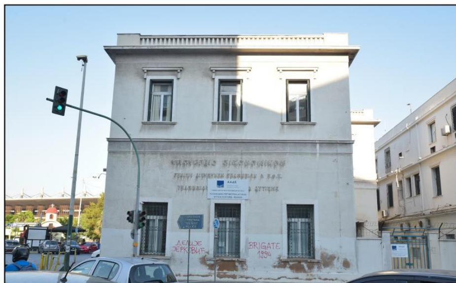
Εικ.2. Η ανατολική όψη του κτηρίου του παλαιού τελωνείου του Πειραιά.
